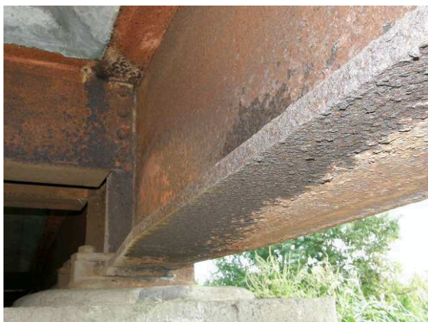
写真 3-11 大沼橋 主桁 主桁の腐食
