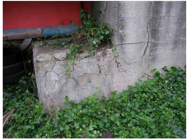
写真 3-8 十川橋 支承 支承の腐食
