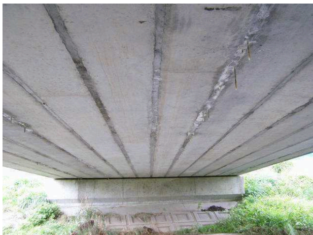
写真 3-5 柏牡沖 1号橋 主桁 間詰め部より遊離石灰の滲出
