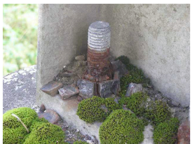
写真 3-12 飯田橋 防護柵(ボルト) ボルトの腐食
