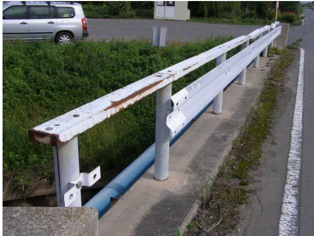
写真 3-1 高増常海 7号橋 防護柵 ビーム部の欠落
