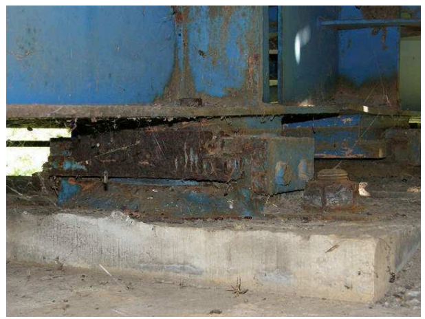
写真 3-10 十川橋 支承 支承の腐食
