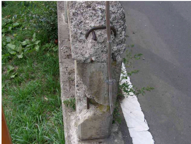
写真 3-9 滝館橋 高欄 コンクリート高欄の断面欠損
