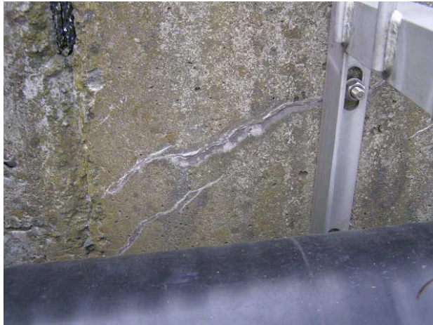
写真 3-7 松元橋 地覆 ひび割れ
