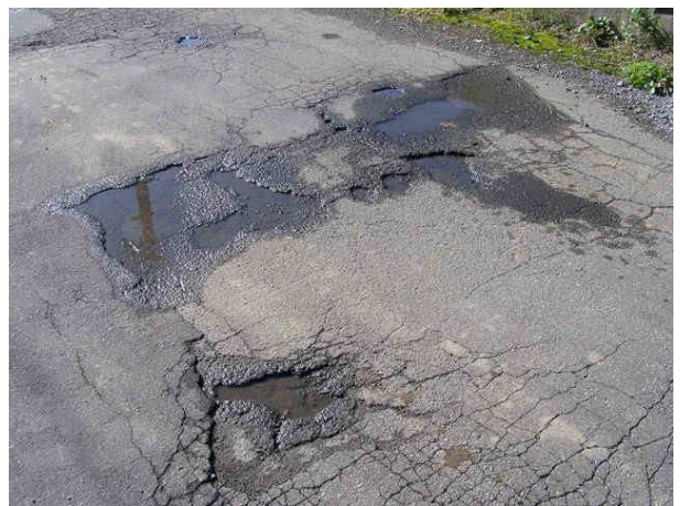
写真 3-4 五幾形本 1号橋 舗装 舗装のひび割れ、穴
