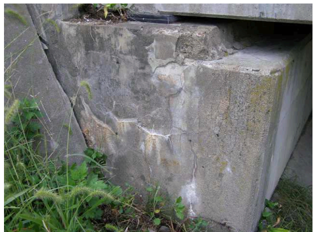
写真 3-6 櫛橋 橋台 凍害によるひび割れ
