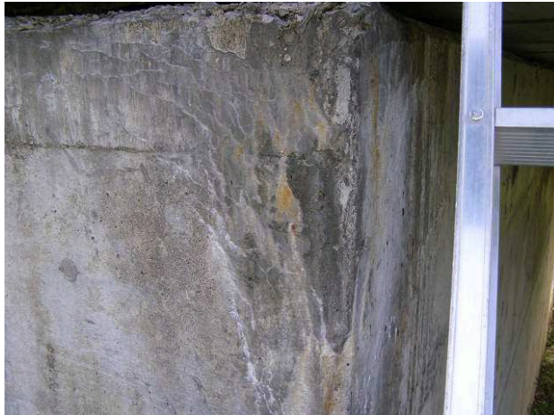
写真 3-3 博亀橋 橋台 凍害によるひび割れ
