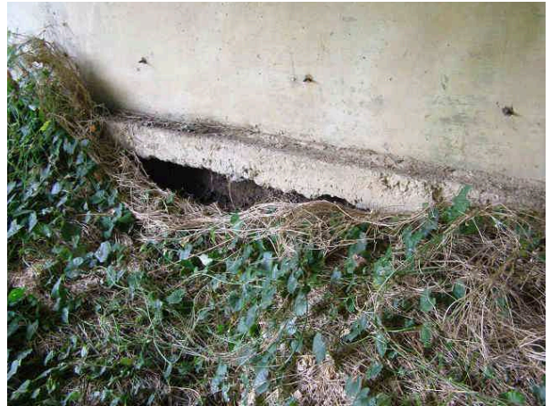
写真 3-2 巖城橋 橋台 橋台前の土砂沈下
